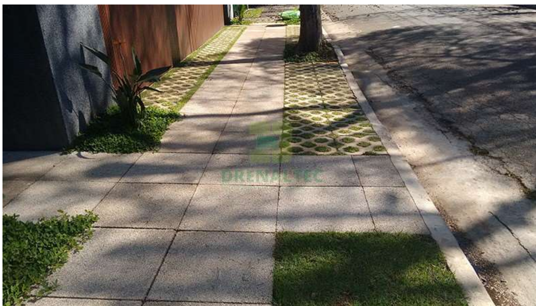
Figura 10: Pisos drenantes. Fonte: Drenaltec
